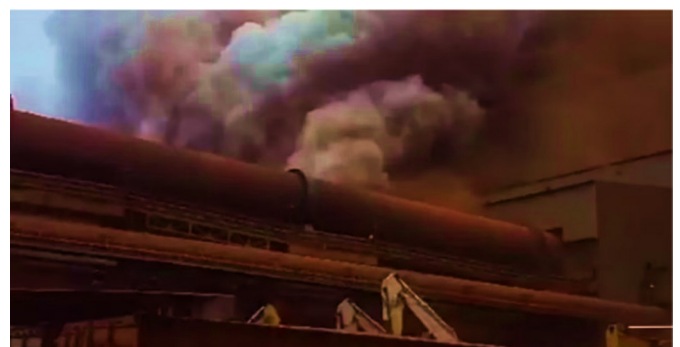
Kebakaran Di Smelter PT. Gunbuster Nickel Industri (GNI) Peledakan Akibat dari Pendinginan Slag Satu pekerja operator Excavator Meninggal (27/09/2023, Foto Heraldulse)
