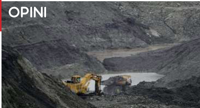
Penggalian Batubara di Front Penambangan
